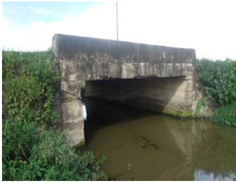
Fig. 5.8.3: Slab Culvert at 339+700
